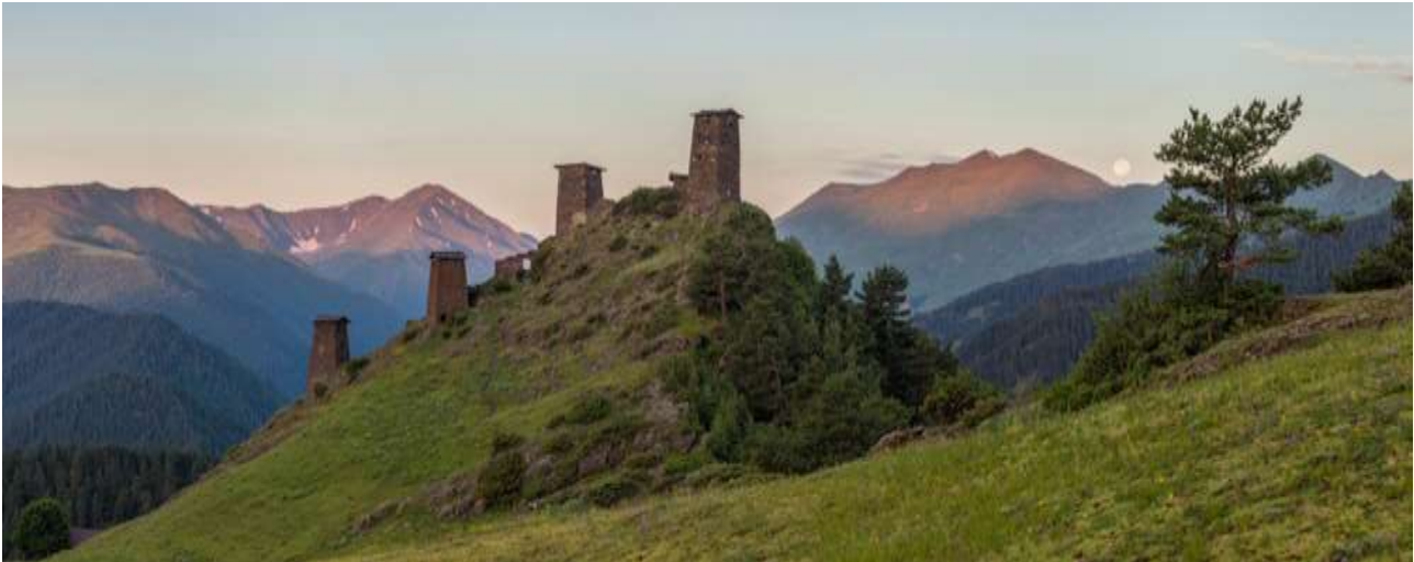
Fästningen Kesolo med sina karaktäristiska vaktorn är strategiskt belägen ovanför byn Omalo.
